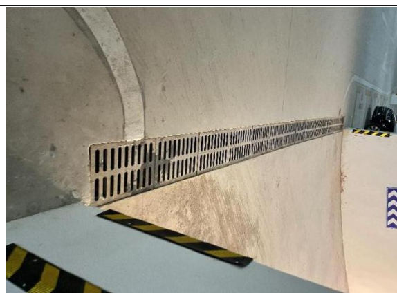
地下停车场截排水沟
