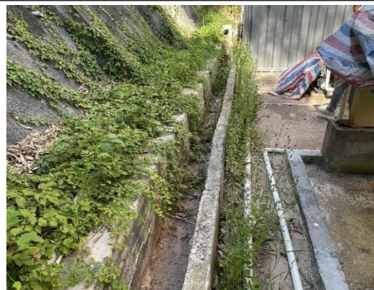
污水处理设施尾水排放沟渠
