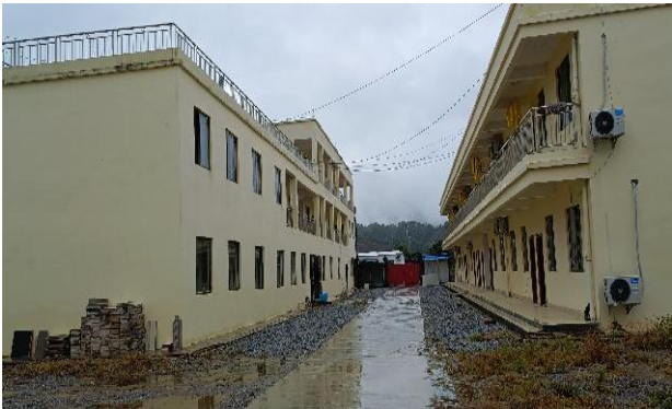
内生活区办公楼
