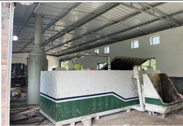
无害化处理车间
